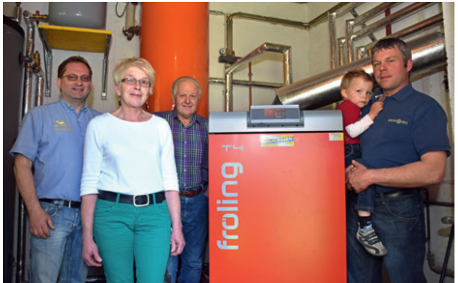
Drei Generationen für eine gesunde Umwelt. Die Familie Gansch mit Haustechnik Bruckner Heizungsprofi Josef Hauer im Kesselhaus.
